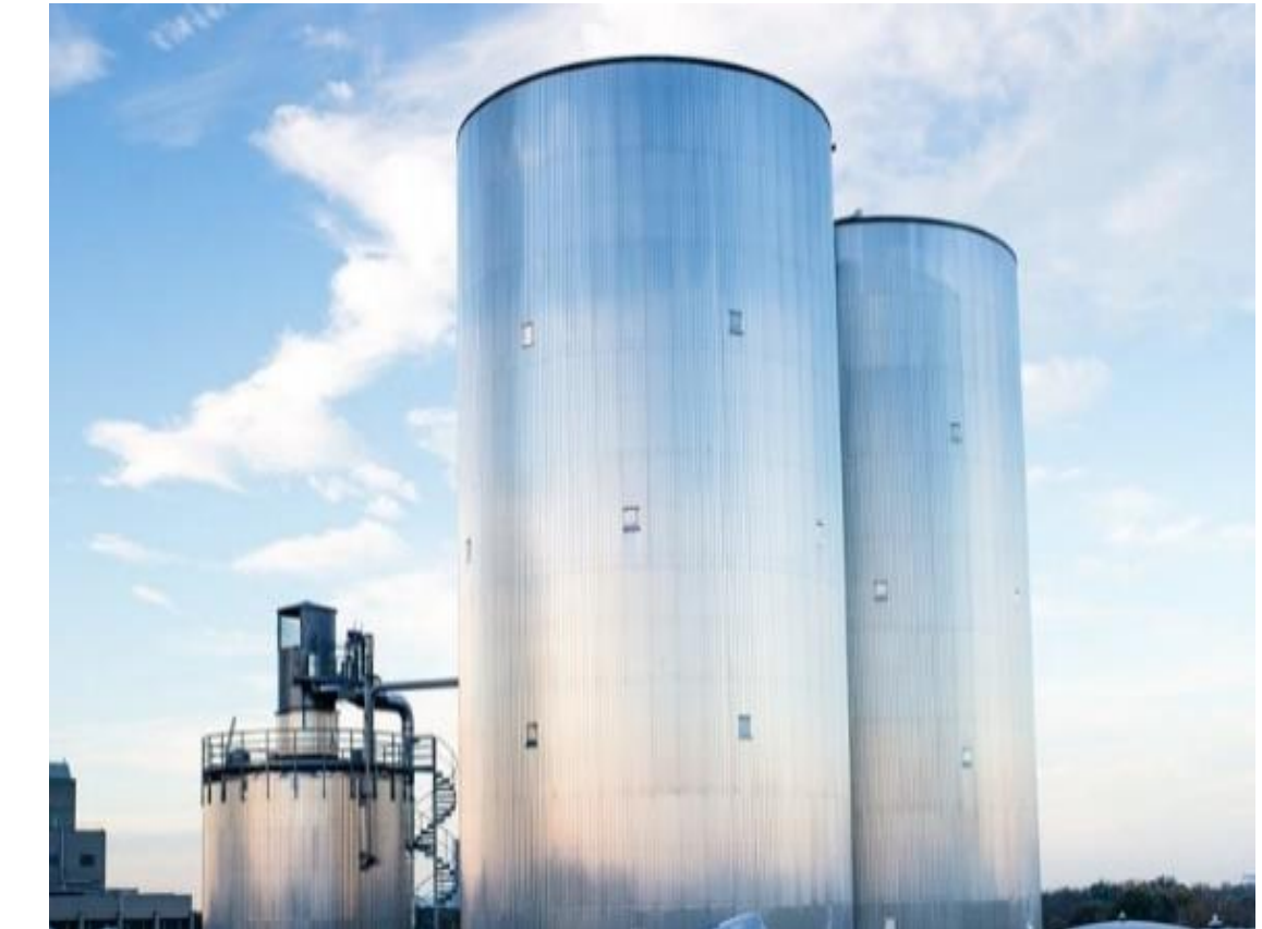
Wien: 2 x 5.500 m 3 , pressure tank storage (Bildquelle: Wien Energie)
