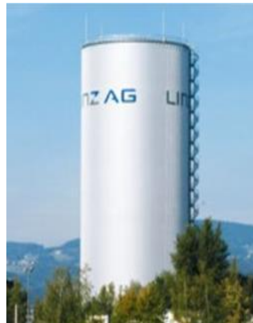
Linz: 34.500 m 3 , pressureless tank storage (Bildquelle: Linz AG)
